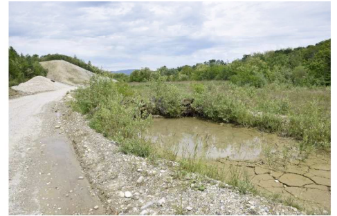
Photographie 12 : Bassin d'infiltration converti en zone humide
