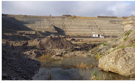
Photographie 8 : Front en cours d'exploitation
